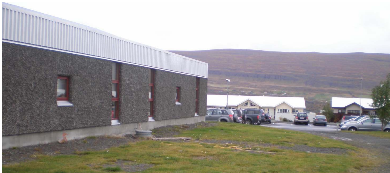
Mynd 7. Séð úr suðvestri að núverandi A-álmnu og því svæði sem fyrirhuguð viðbygging mun ná yfir.
