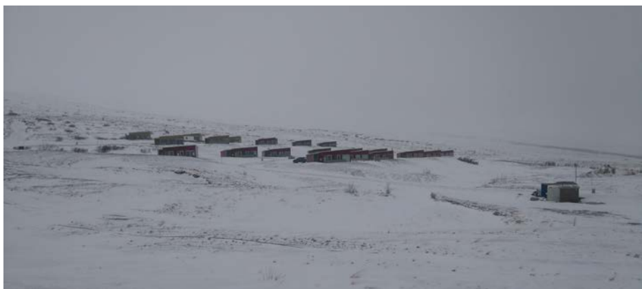
21 frístundahús hefur verið byggt á svæðinu samkvæmt skipulagi 2. áfanga.
