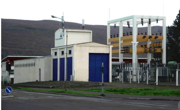
Mynd 23. Spennistöð Akureyrar. Arkitekt Sigvaldi Thordarson. Ljósmynd B.j.
